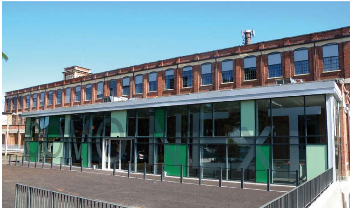
L'edificio ad opera compiuta: una pensilina preesistente è stata chiusa con una vetrata a telaio e pannelli colorati che creano l'atrio d'ingresso e una sala esposizioni.
