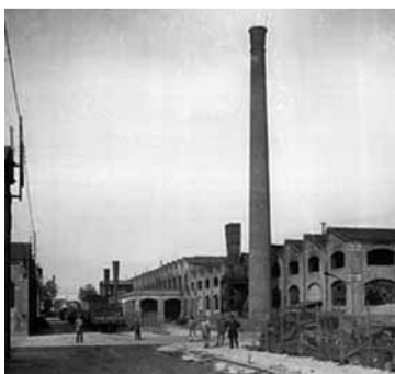
Area Breda, vista storica.
